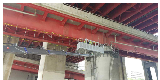
① 클램프 및 와이어로프 설치
