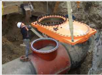
Sandwich Valve 설치
